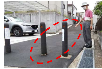
道路舗装整備
