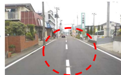
道路舗装整備
