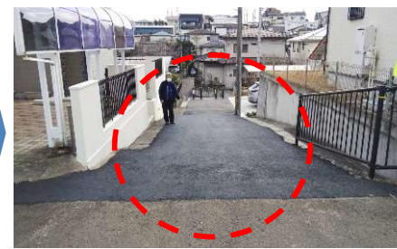
舗装の改修 安全対策
