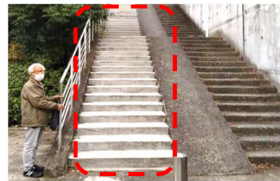
階段改修 安全対策
