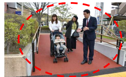
スロープ新設 バリアフリー対策
